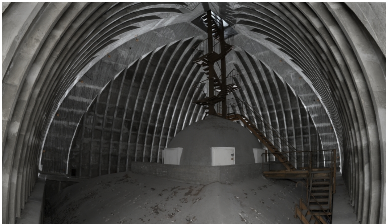
Le dôme Soufflot. Vue d'ensemble de la charpente en béton
