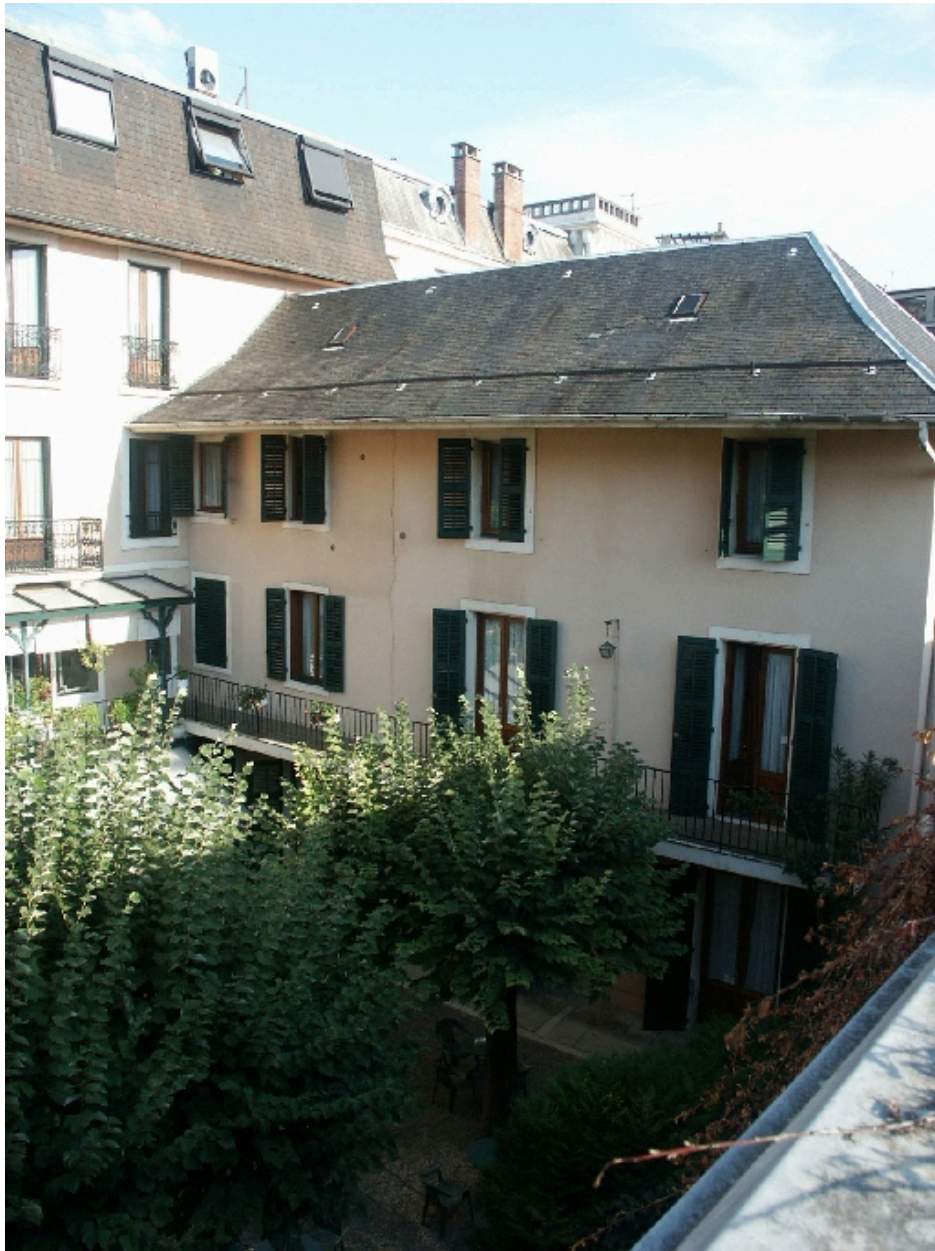
Elévation sur cour de l'aile sud
