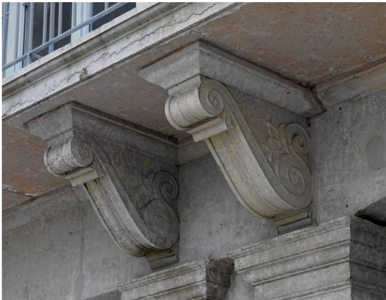
Consoles XIXe siècle, cour, aile sud
