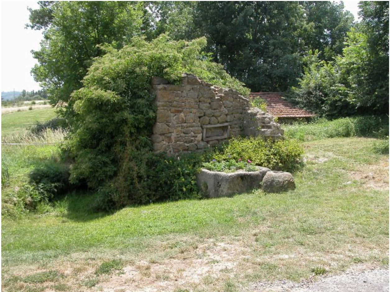
Prassouroux (1986 AL 69). Abreuvoir, vue d'ensemble.
