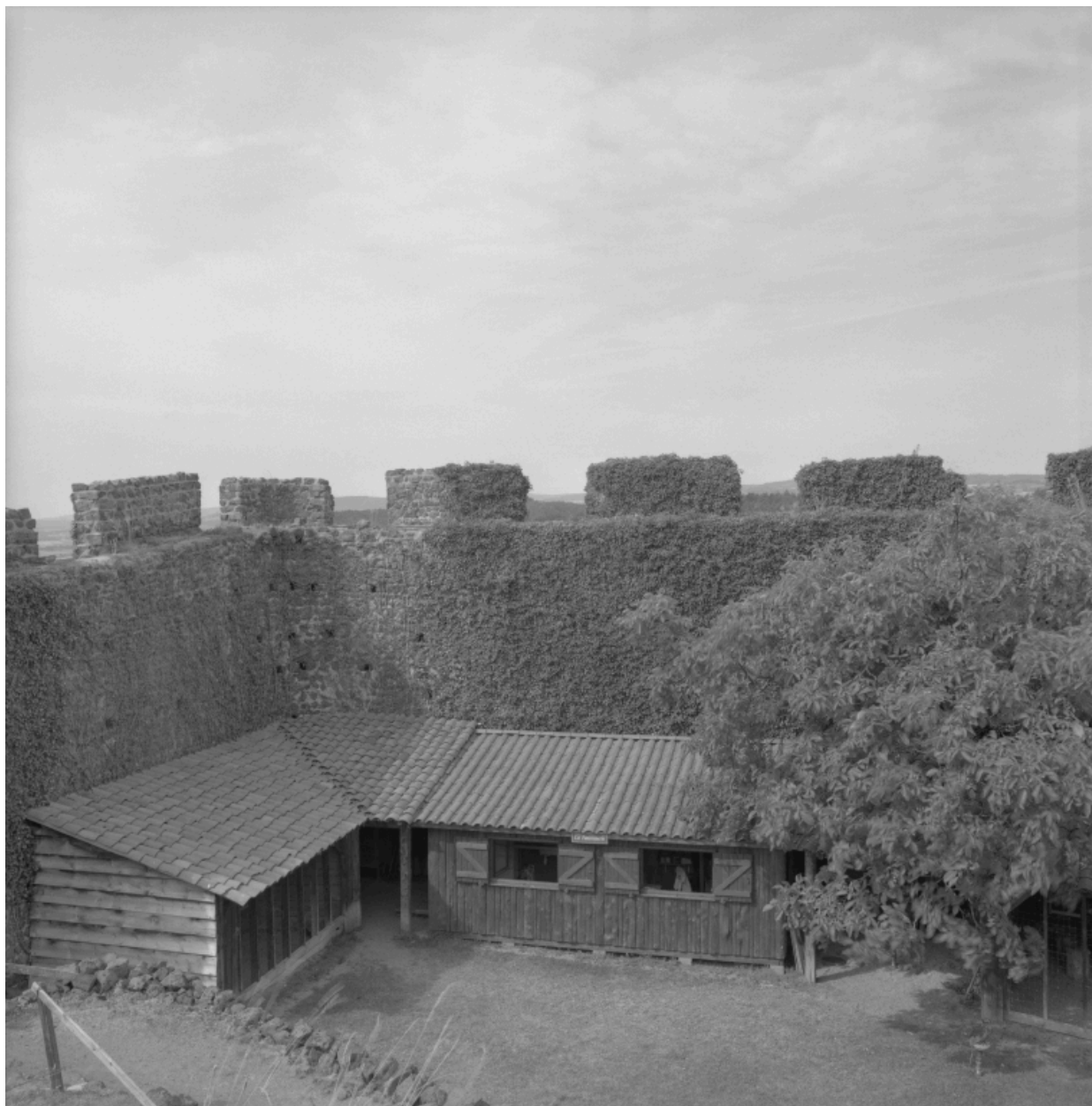
Vue intérieure générale de l'angle sud-ouest de l'enceinte, depuis le nord-est : crénelage, chemin de ronde.
