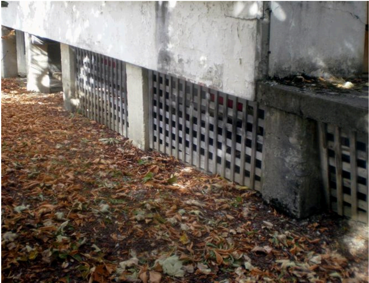
Détail de la claustra de la façade sud, côté ouest
