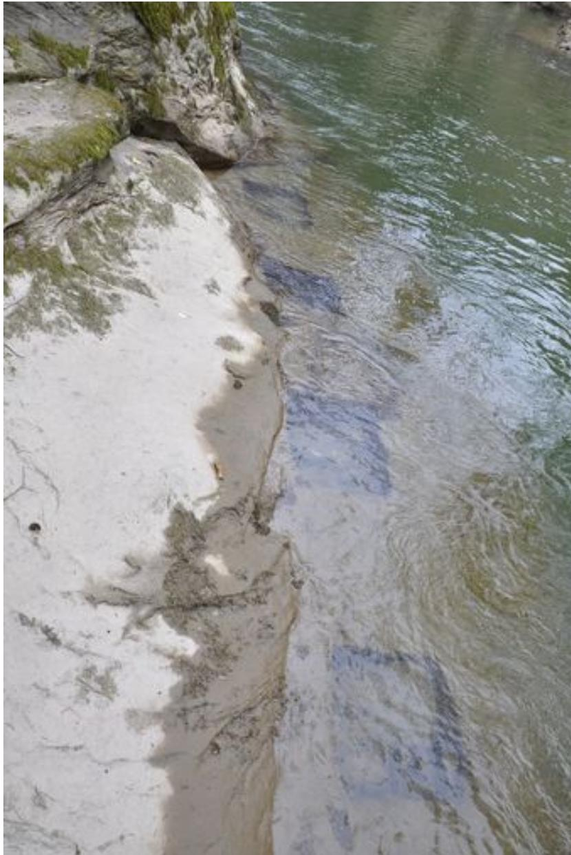
Détail des encoches supportant les poteaux de bois rive droite
