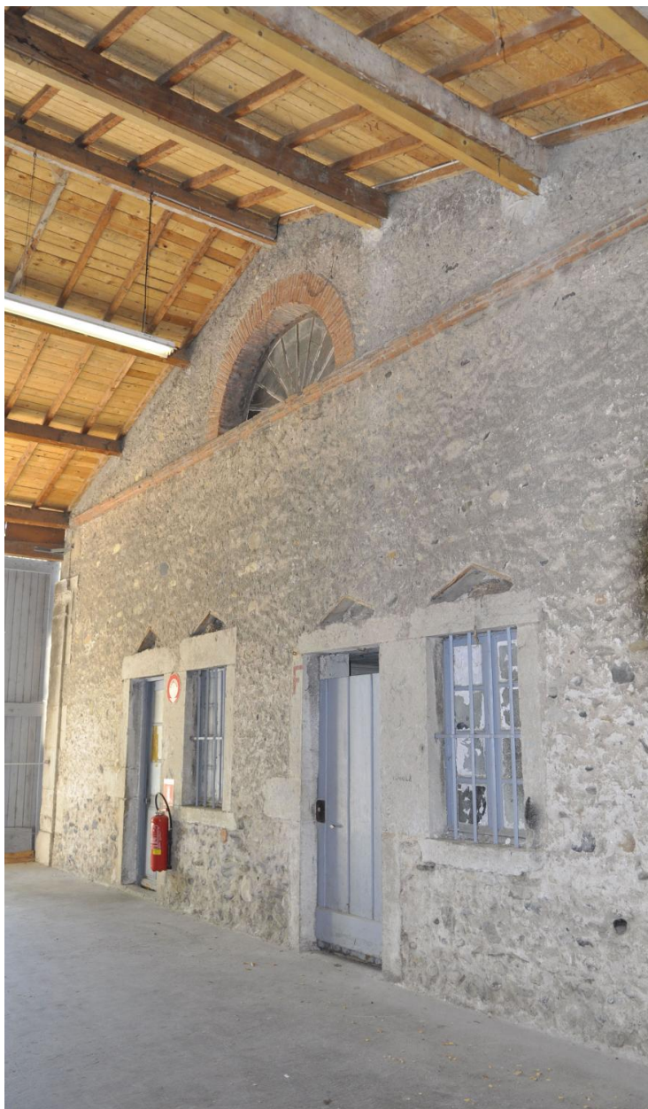
Pignon convert (vue d'intérieur)
