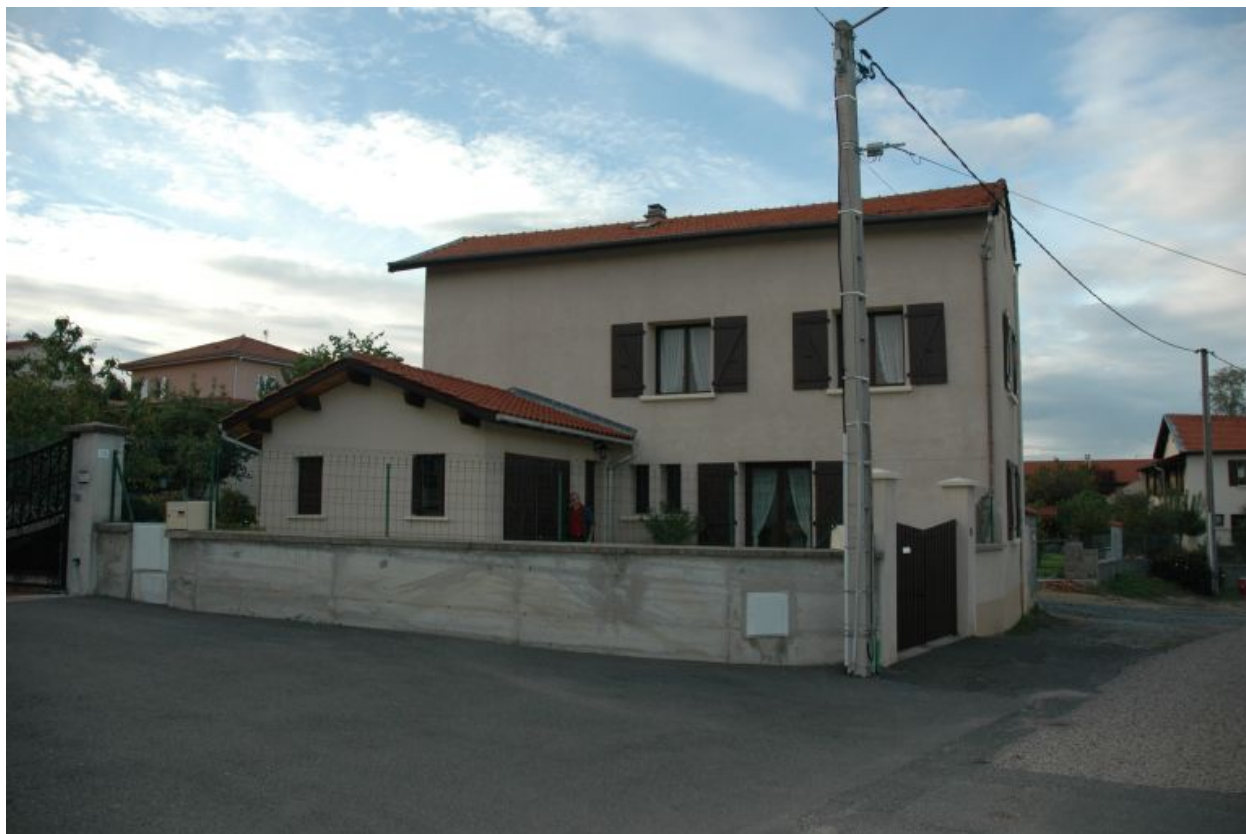
Cuvage transformé en ferme (Montbrison, Moingt, Sous Rigaud, AC 201).
