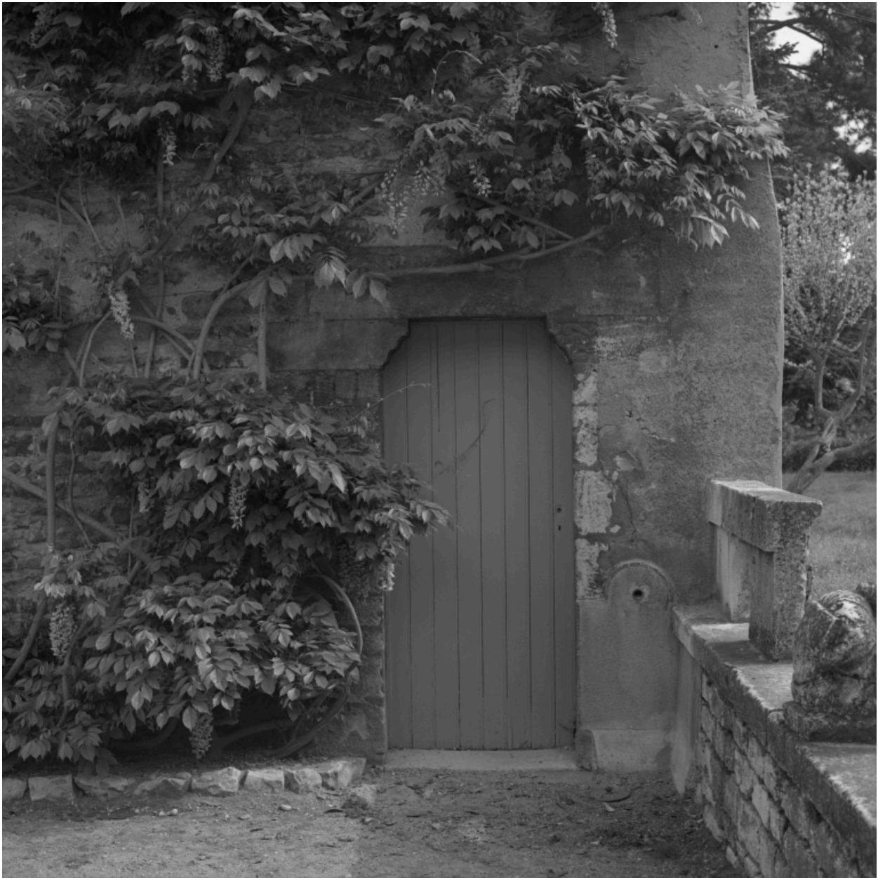
Aile droite élévation sur cour, détail : porte piétonne.
