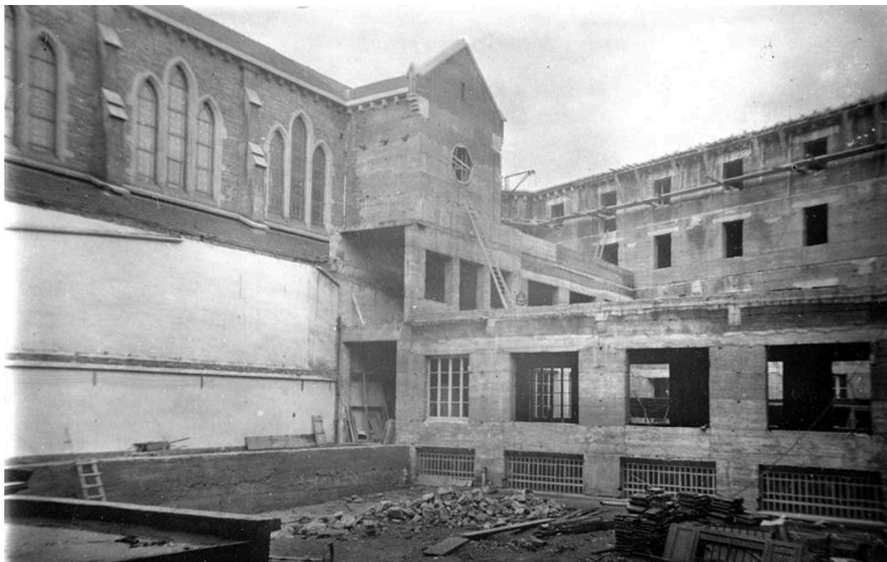
Construction de la maison provinciale. Photogr., 1924 (A. Missions africaines)
