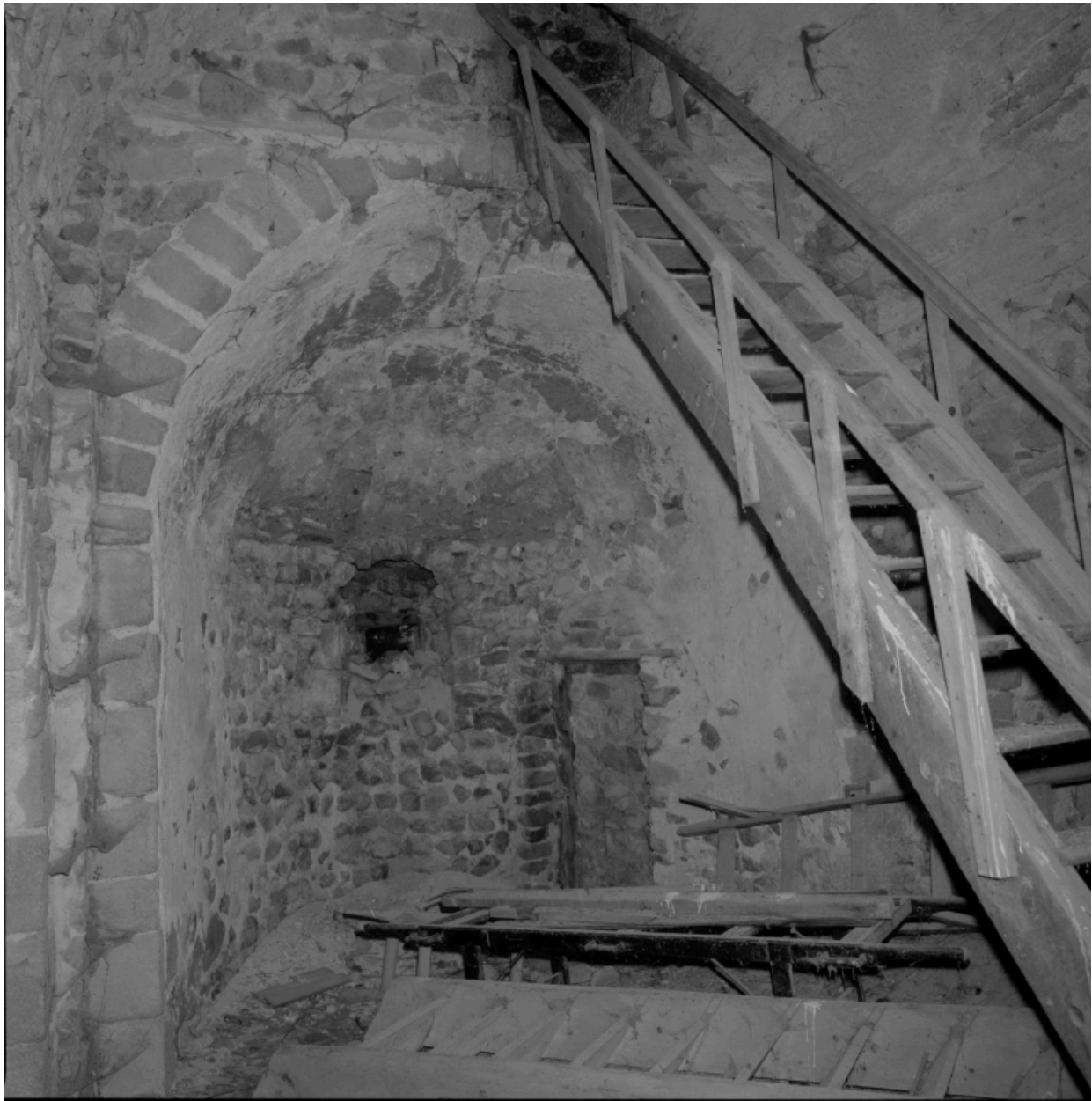
Vue intérieure de la salle haute du clocher : abside.
