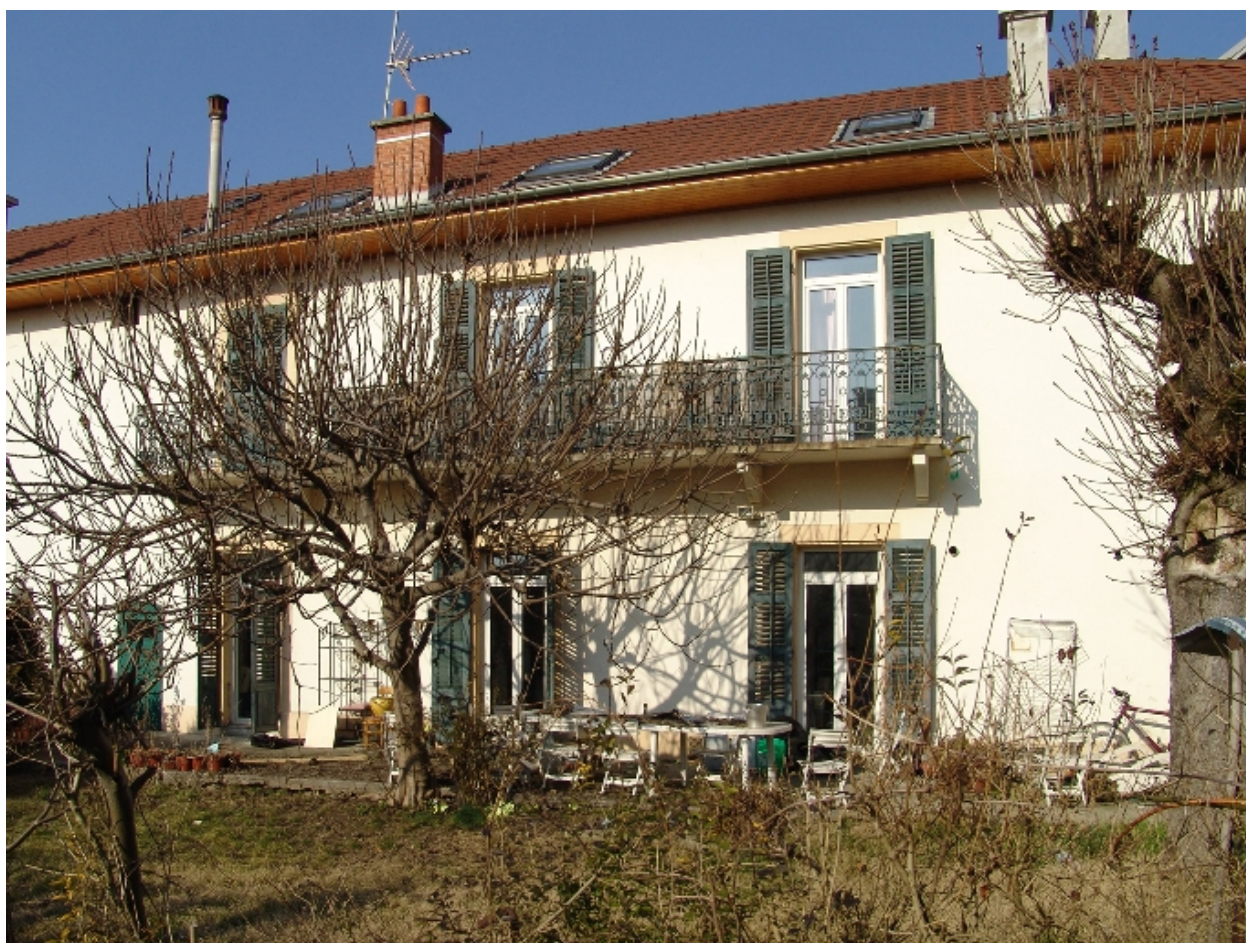
Façade sur jardin, partie droite
