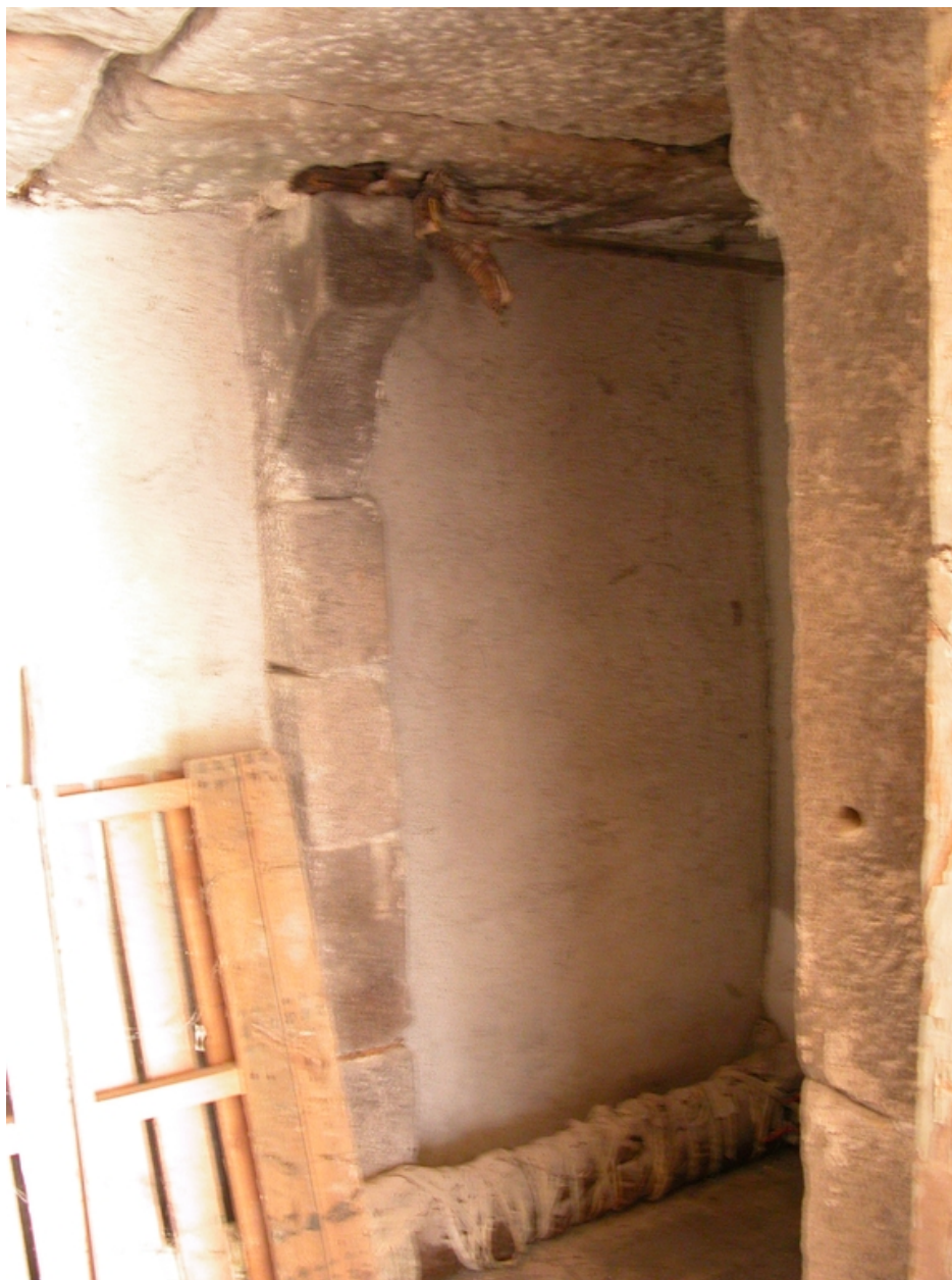
Vue intérieure du logis : l'escalier, accès à la cave.
