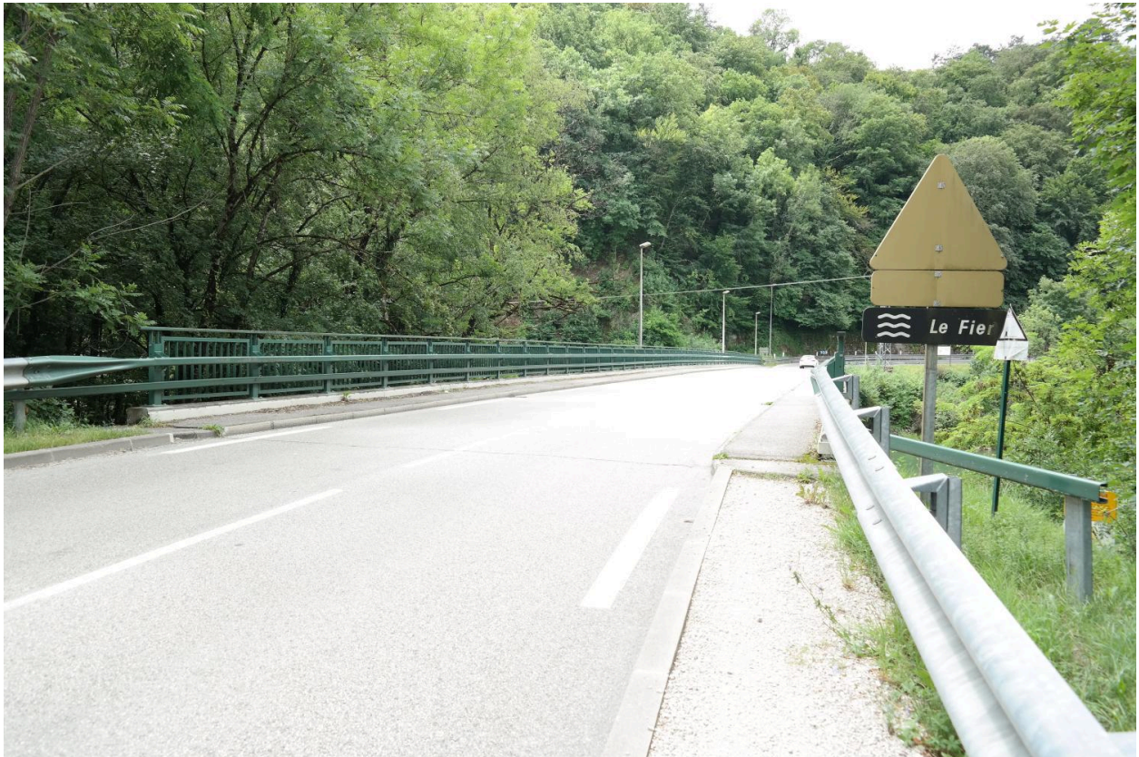
Pont du Fier. Vue sur la chaussée.
