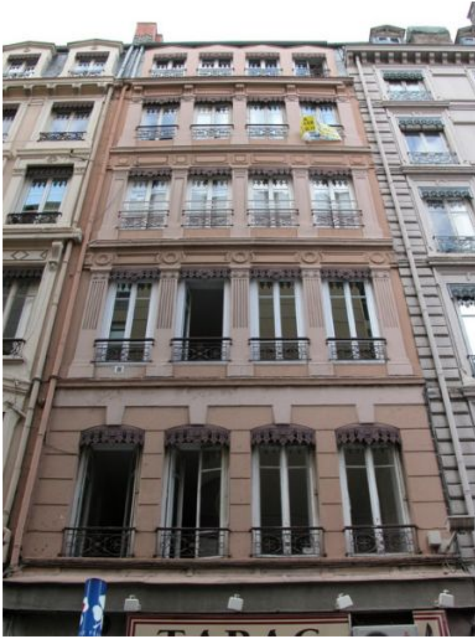
Façade, vue par-dessous
