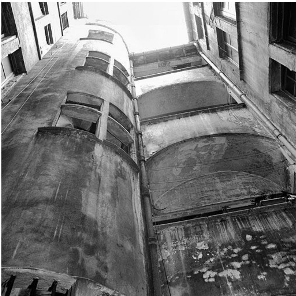
Cour intérieure : cage d'escalier demi-hors-oeuvre et galerie desservant les appartements
