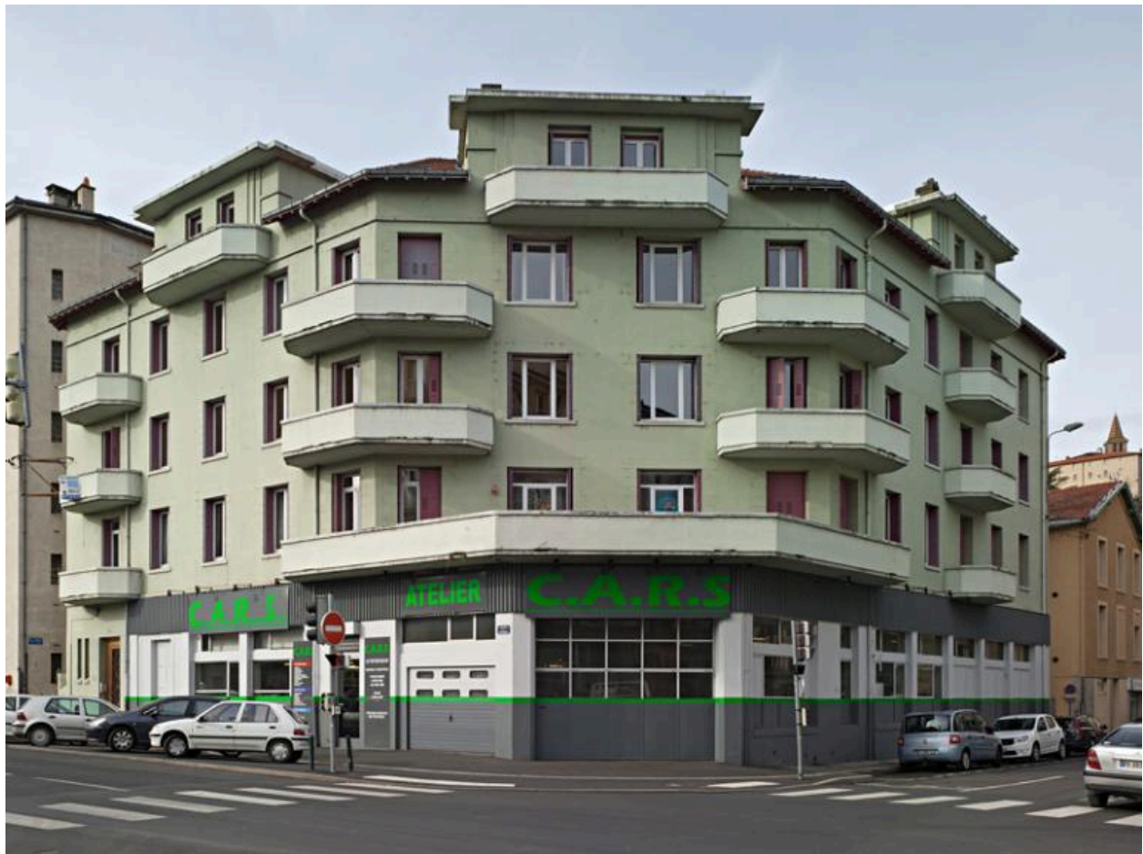
Le Puy-en-Velay (Haute-Loire). Boulevard de la République : immeuble composant monumentalement avec le pan coupé.
