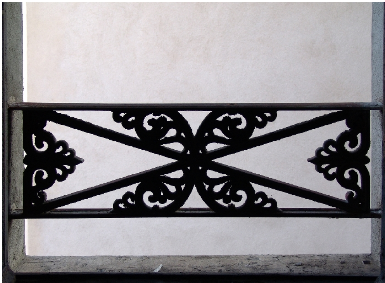
Garde-corps du 2e étage, côté rue
