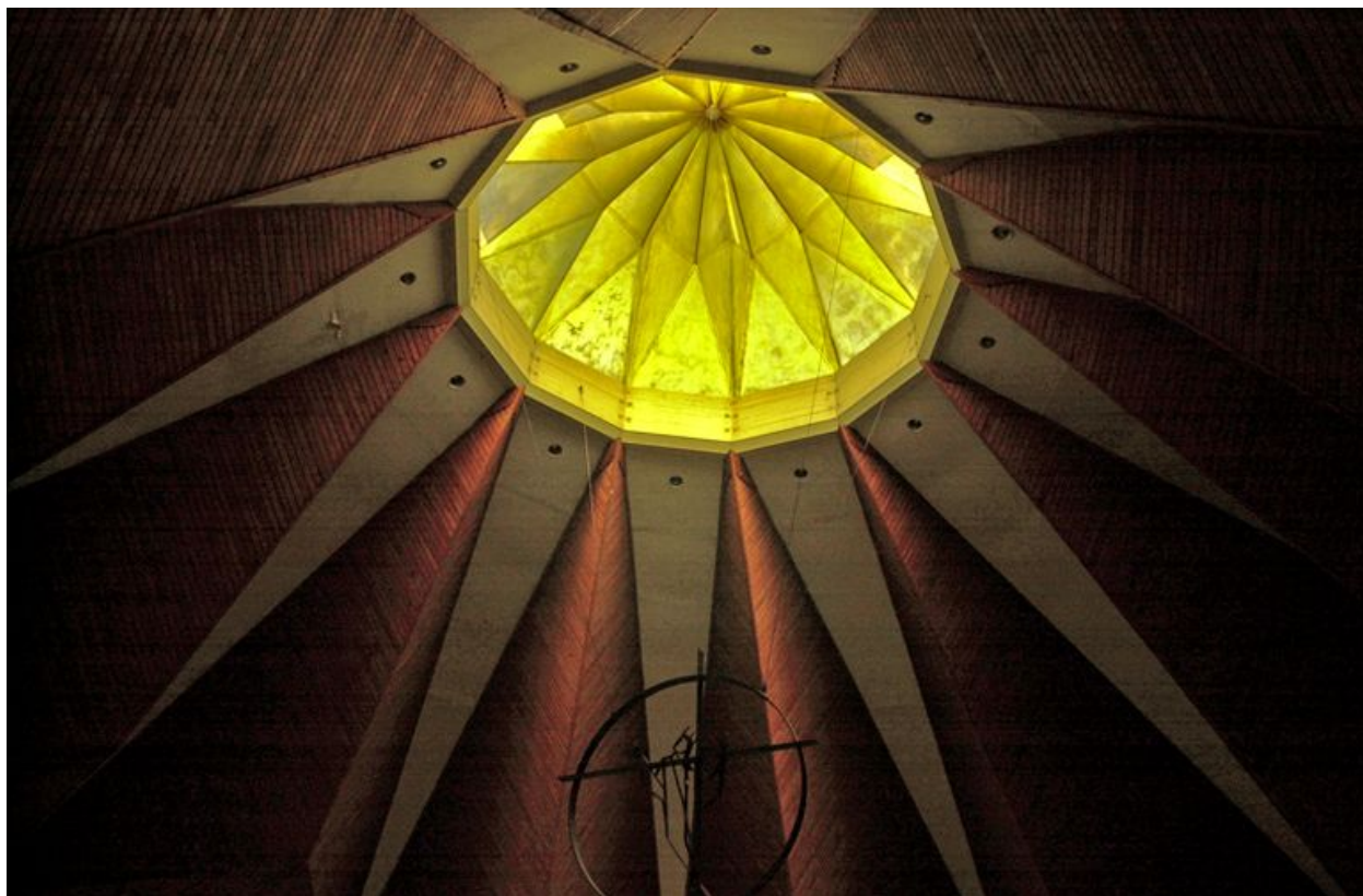
Détail du lanternon
