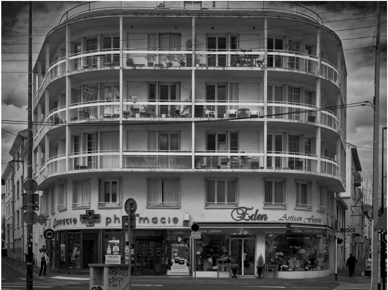
Façade sur la place Littré
