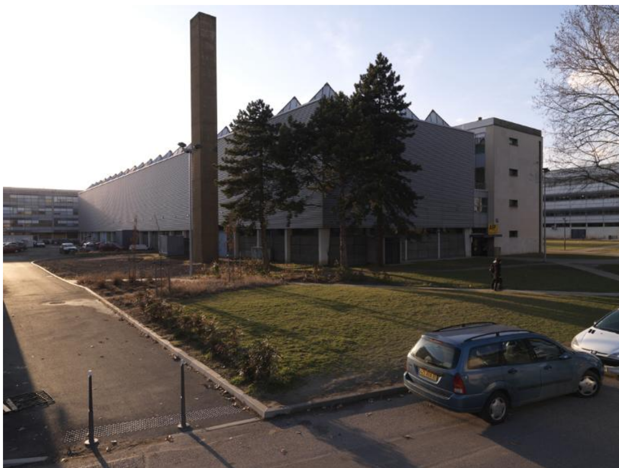
Vue d'ensemble de la halle
