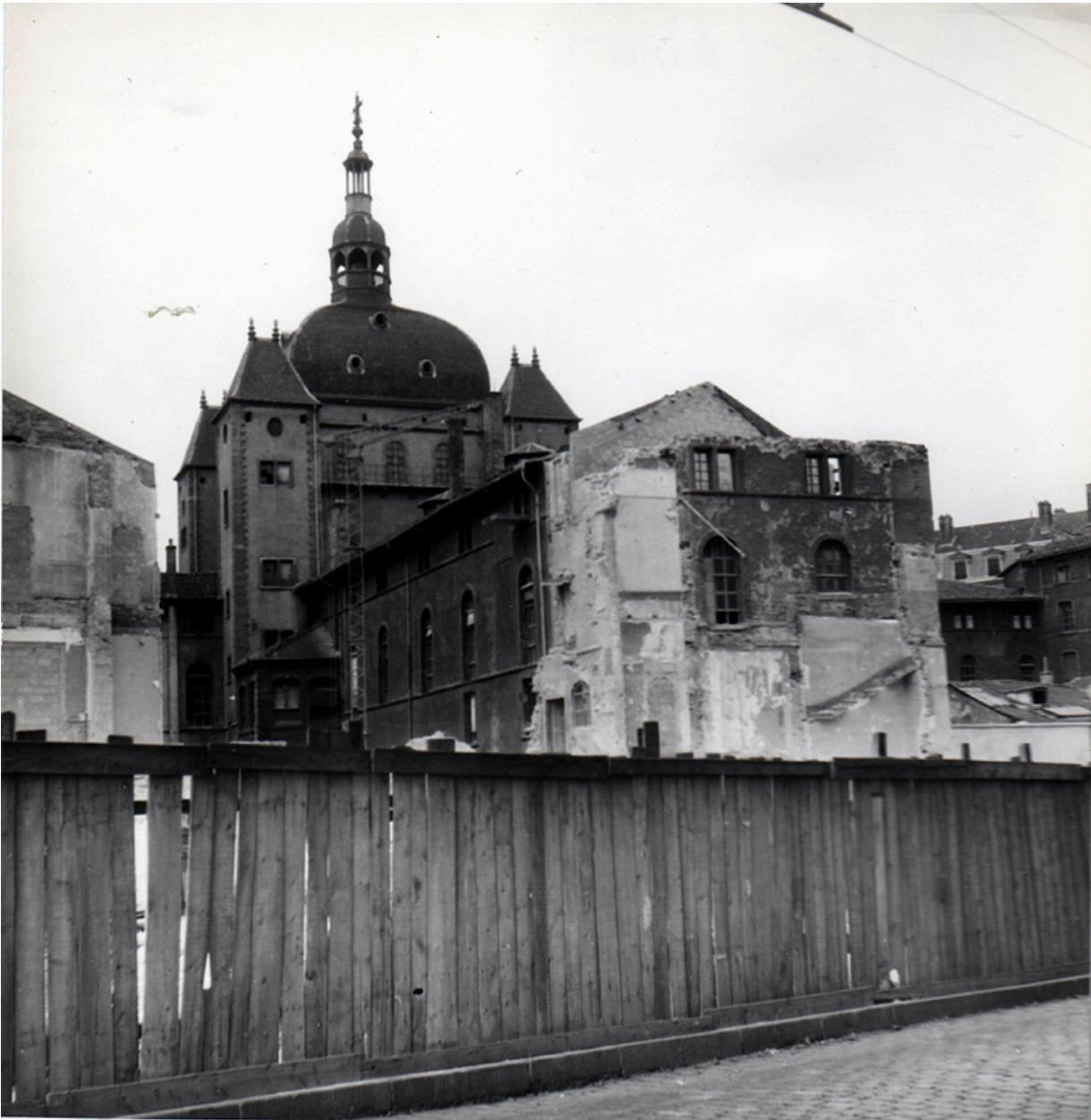
Démolition du passage, l'espace libéré au niveau du bâtiment O et de la cour de la Pharmacie
