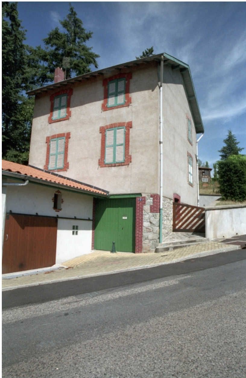
Boën, îlot 12, Henri Dunant (boulevard) 8. Vue générale de la façade sur rue.
