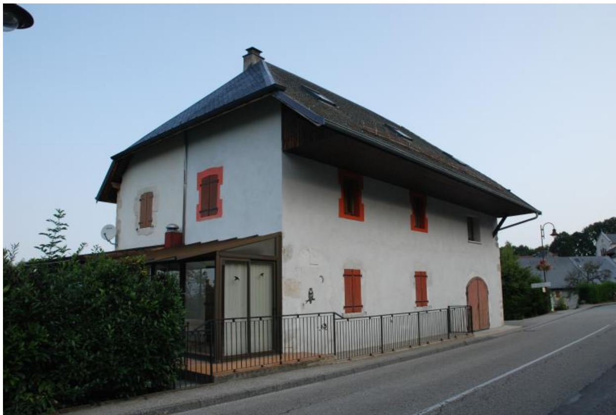
2015 C3 1010, Grand Maison (la), ferme. Vue d'ensemble depuis la route de l'ancienne façade principale.
