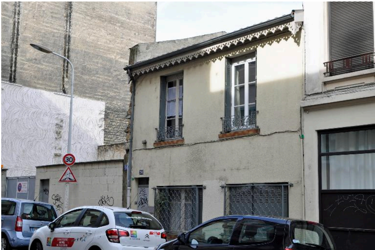
Vue générale, élévation sur rue
