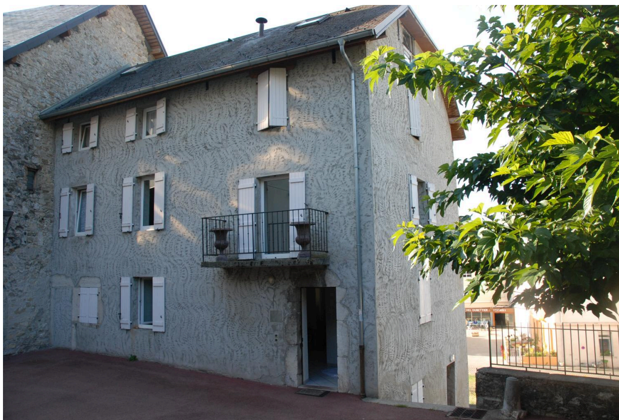
Maison, immeuble, place Charles-Albert (2018 E1 313). Elévations sur la place.
