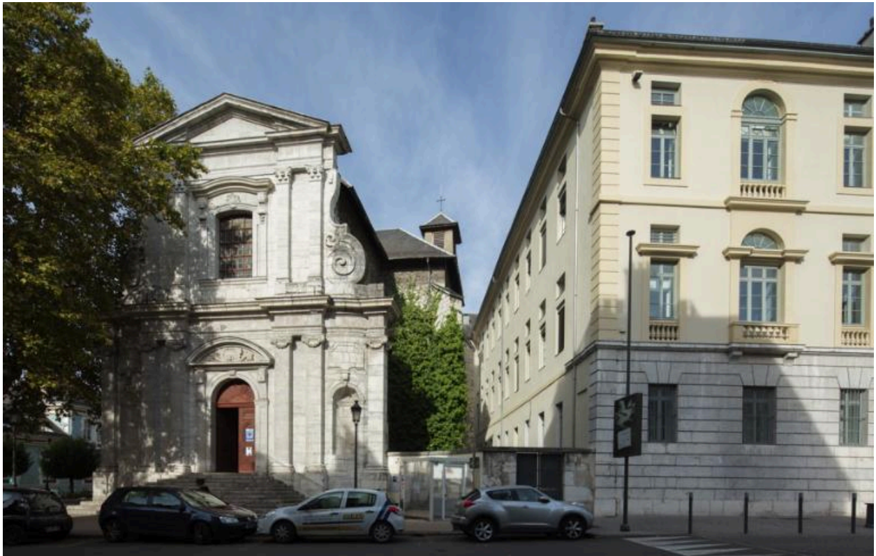
Bâtiment en H, façade de l'aile C et église de l'ancien couvent de la Visitation.
