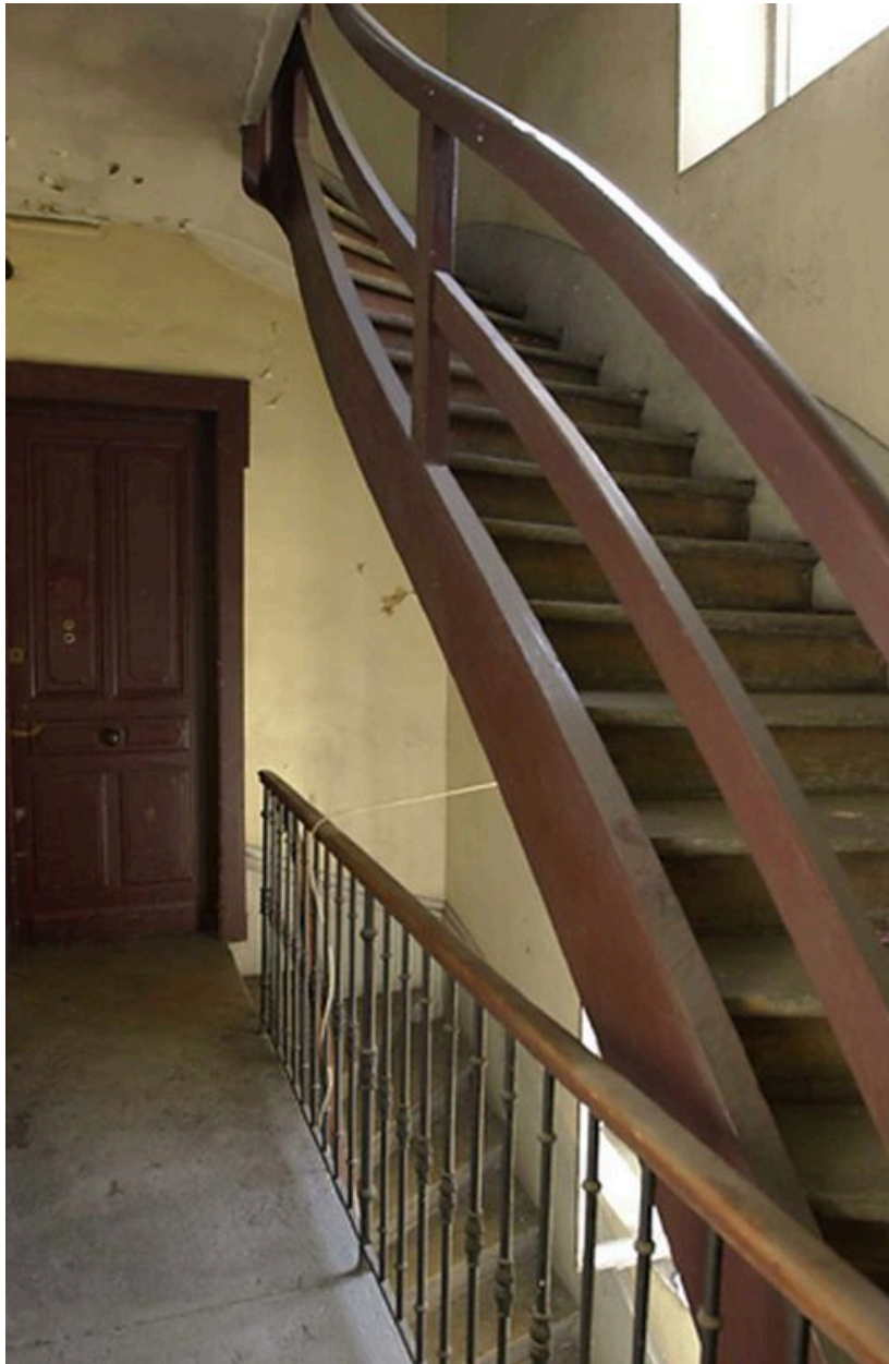
Dernière volée en bois de l'escalier
