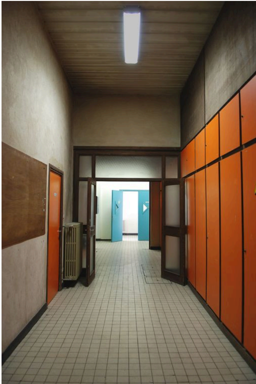
Bâtiment ISARA (2nd tranche), couloir du rez-de-chaussée.
