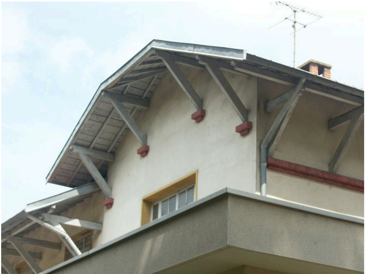
Bâtiment Nord Ouest, détail de toiture
