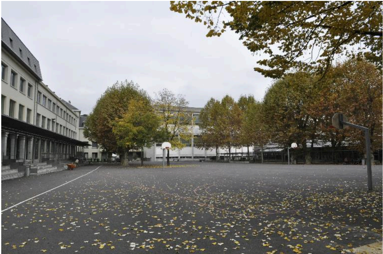
Cour intérieure, vue générale depuis le sud-est
