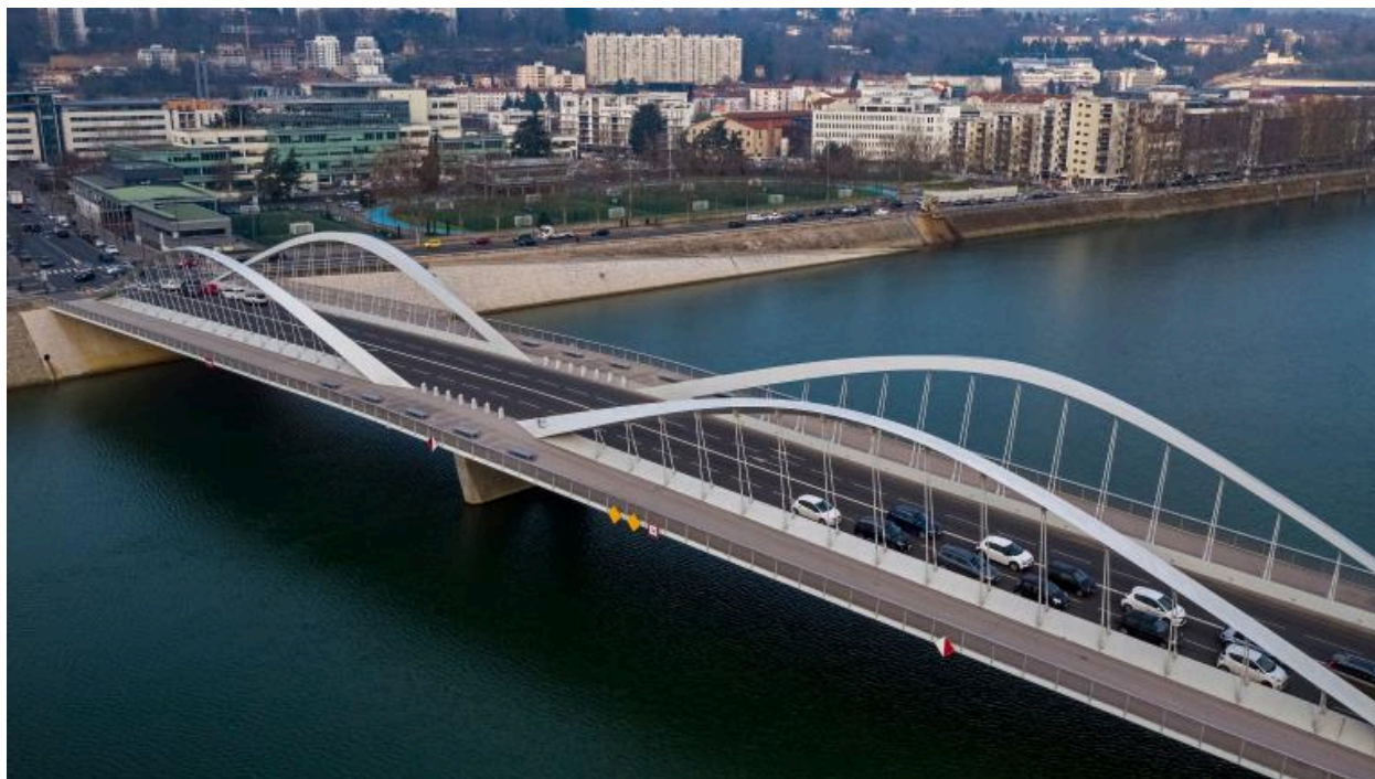
Vue d'ensemble du tablier du pont Schuman (drône)
