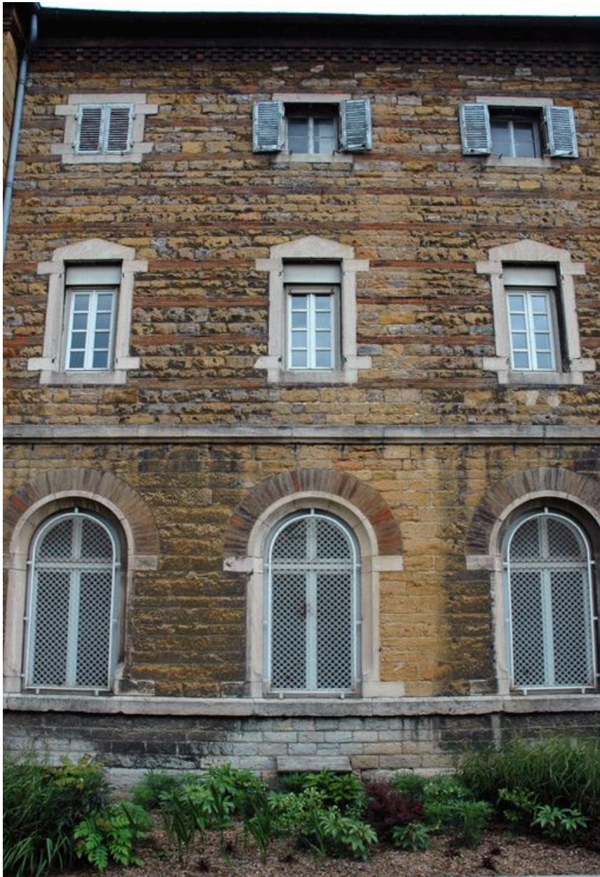
Elévation latérale nord, détail de trois travées
