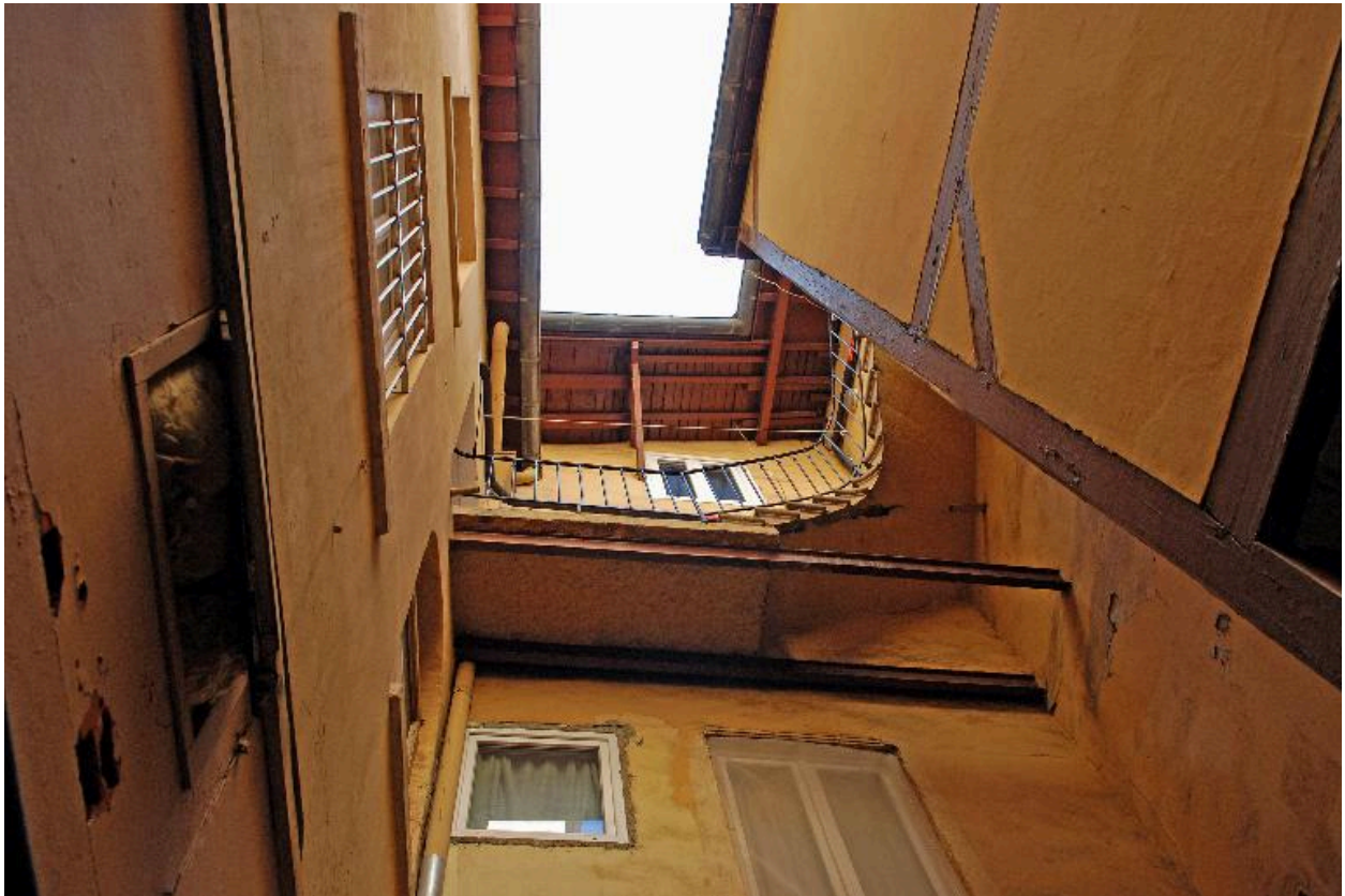
Vue de la cour, bâtiment est : galerie reliant les deux immeubles au troisième étage
