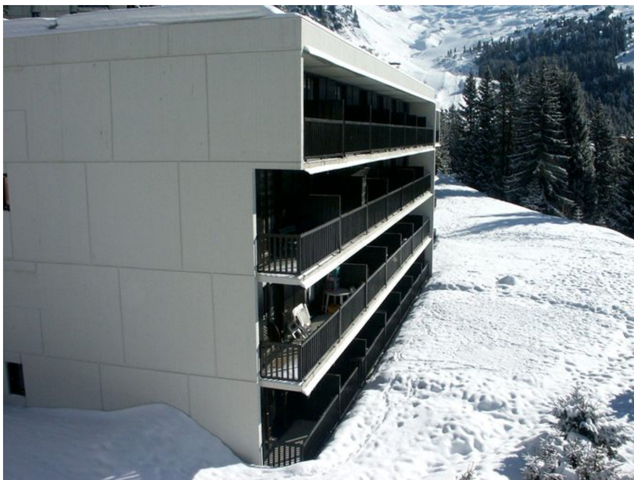
Elévation sud depuis l'ouest
