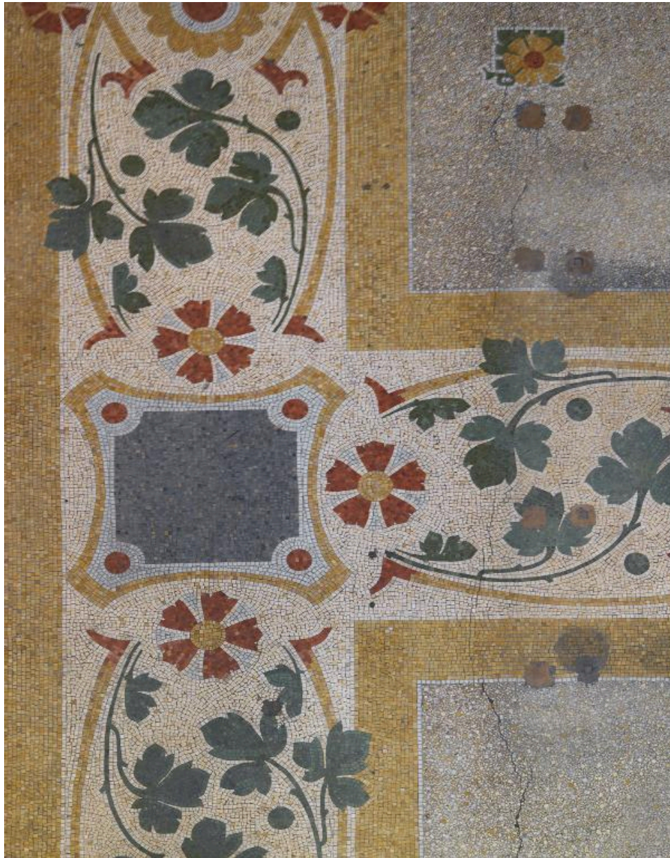
Brasserie La Taverne : revêtement de sol en mosaïque et granito, matérialisation de cheminements perpendiculaires
