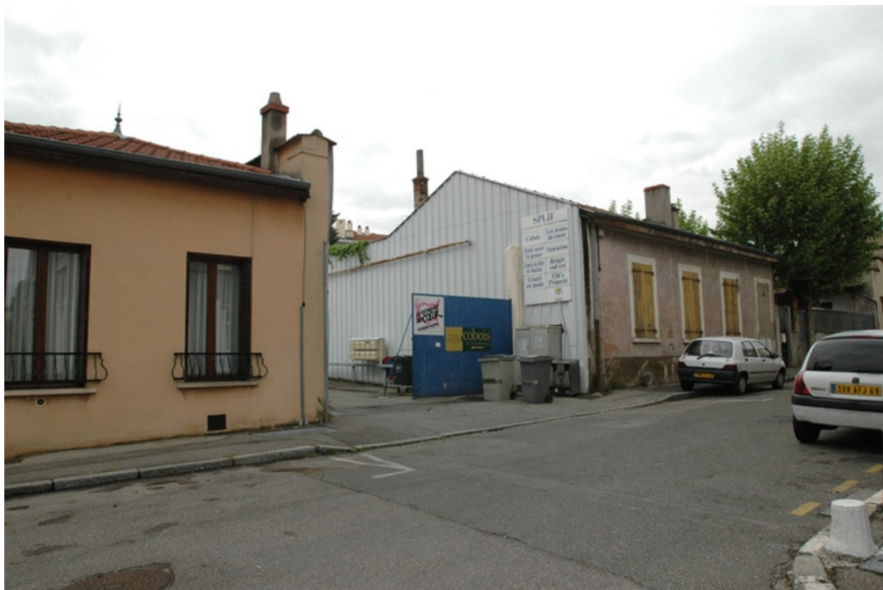
Entrée principale et atelier attenant, vue ouest.
