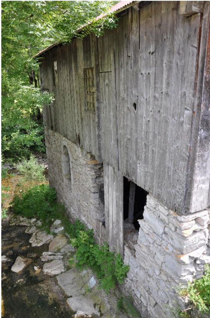
Vue de la façade nord.
