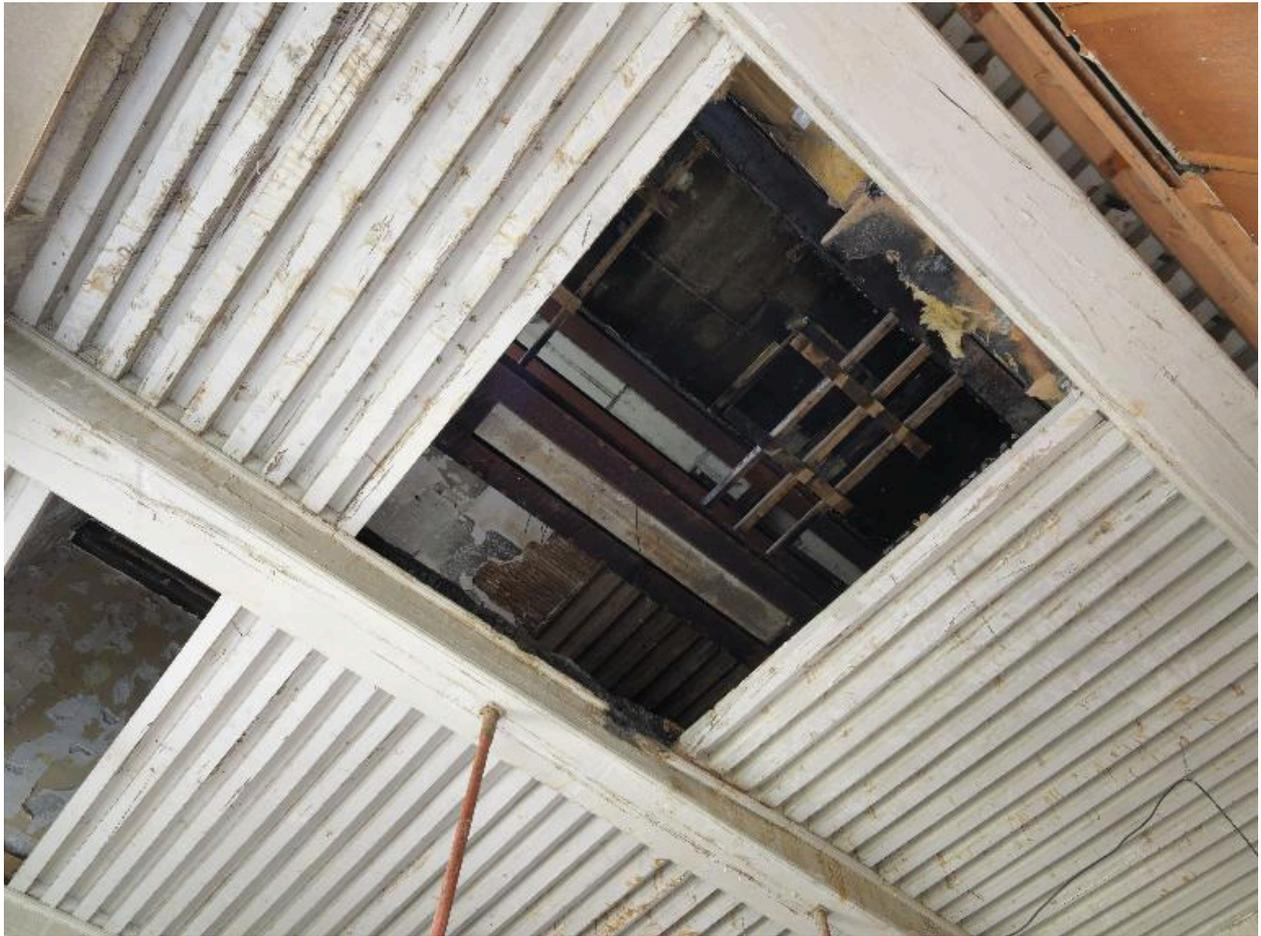
Prieuré, intérieur : plafond du rez-de-chaussée et planchers des étages supérieurs visibles en raison de l'incendie survenu le 30 décembre 2012
