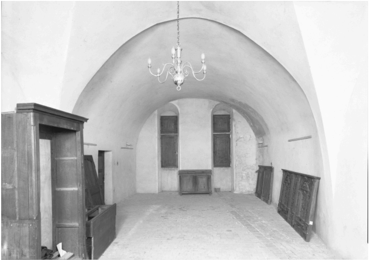
Corps dit "de garde", rez-de-chaussée surélevé : vue générale de la dernière "cellule" prolongée par un espace voûté d'arêtes et dite la "salle de justice", de l'ouest.
