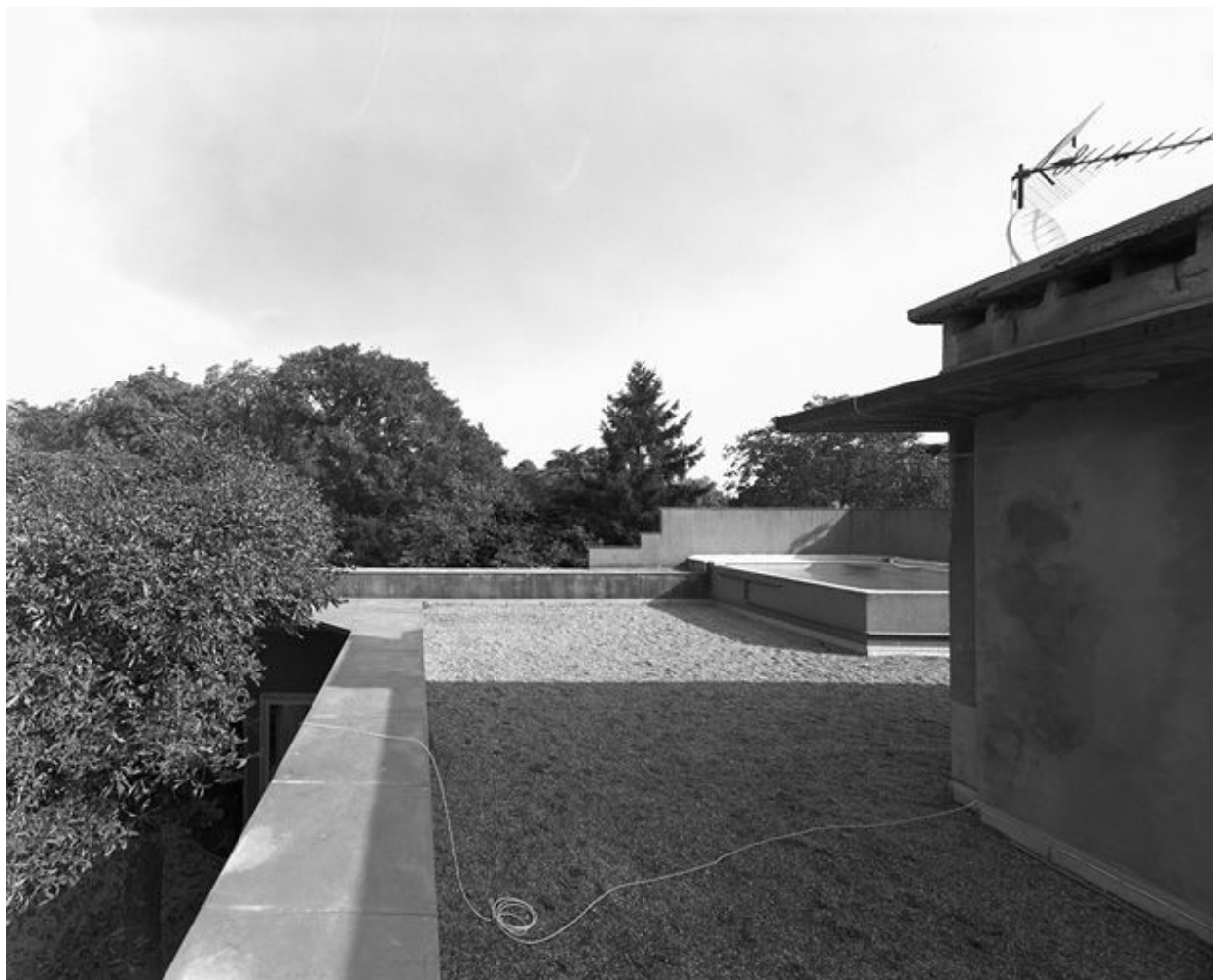
Logis, partie ouest du toit en terrasse
