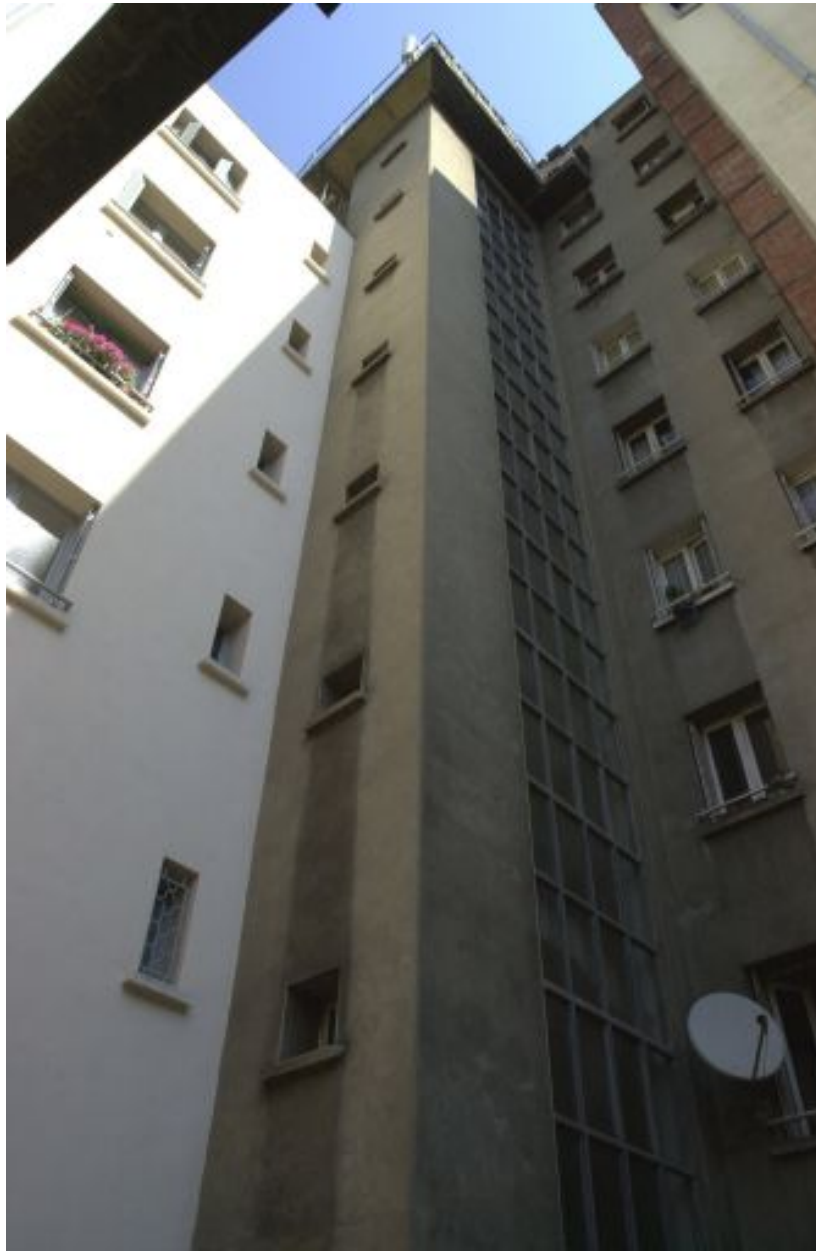
Elévation postérieure sur cour : la tour d'escalier
