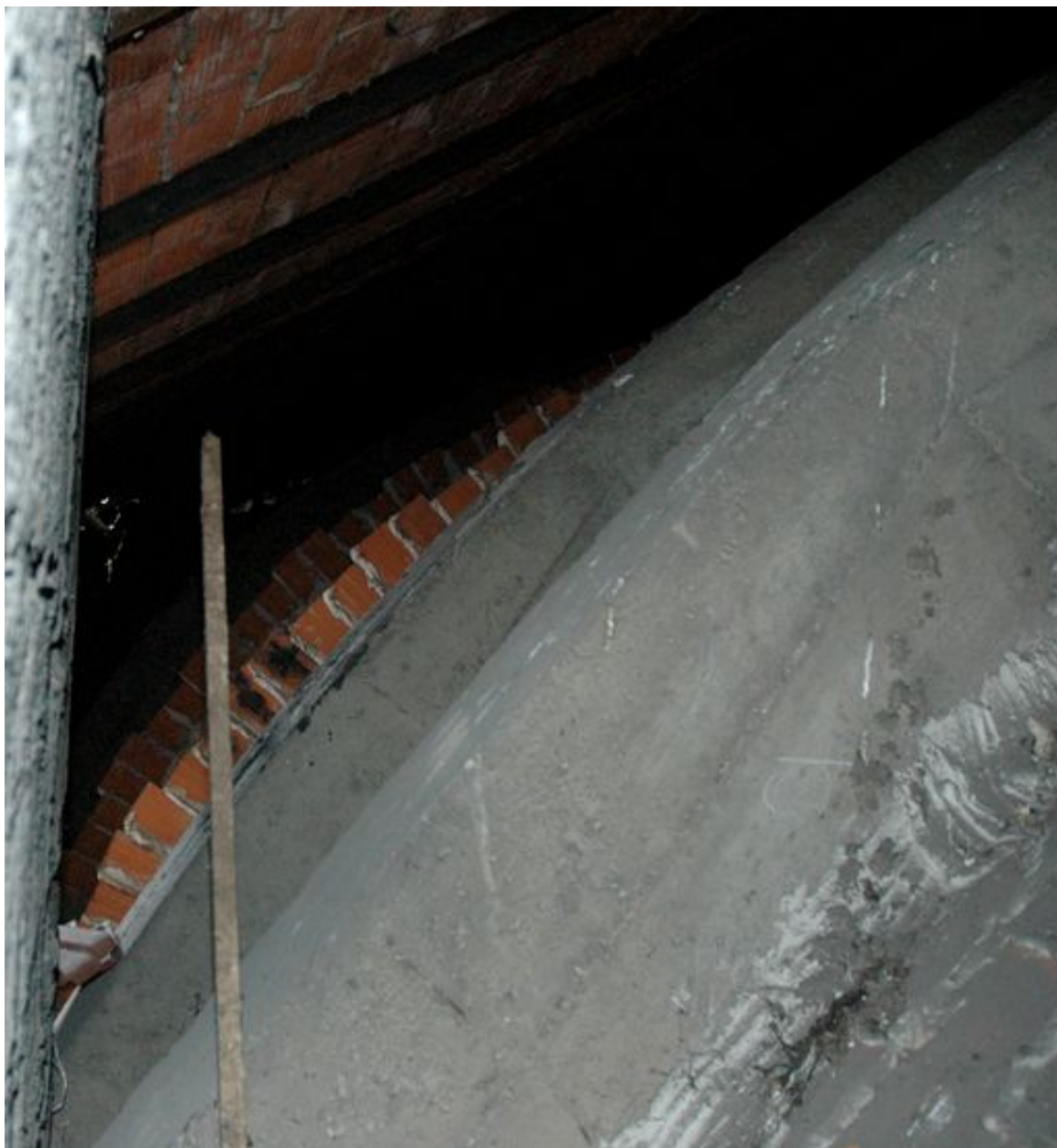
Détail des voûtes de l'église
