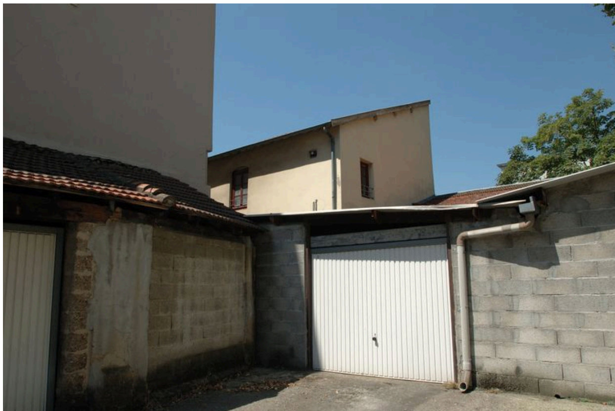
Vue des garages et entrepôts situés au 92 rue du Bourbonnais.
