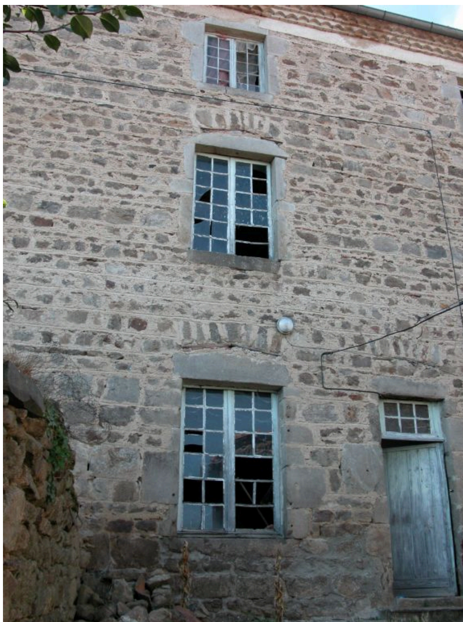
Travée de gauche du logis de la parcelle 259.
