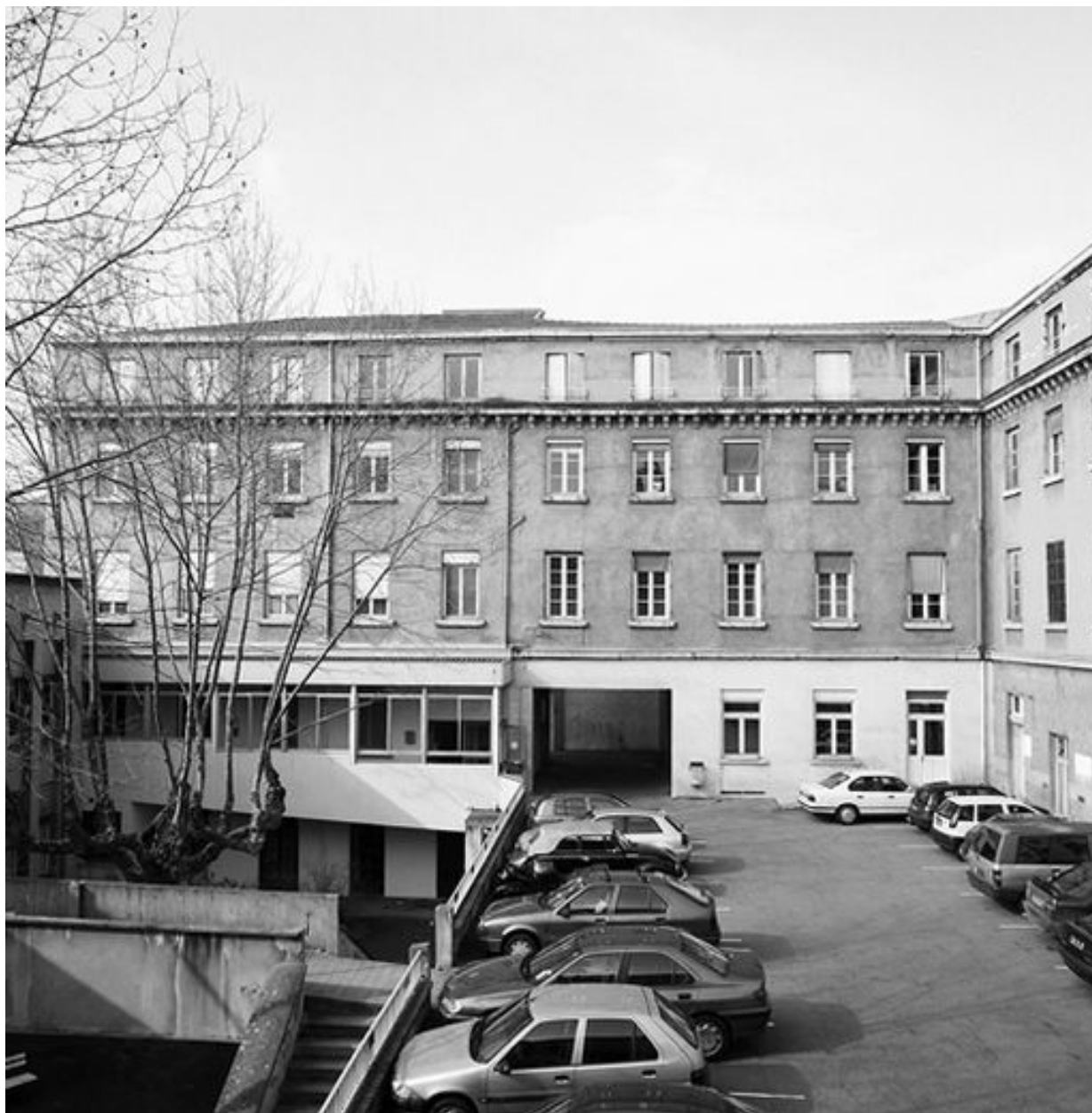
Bâtiment 9, façade de l'aile bordant les terrasses 11 et 10
