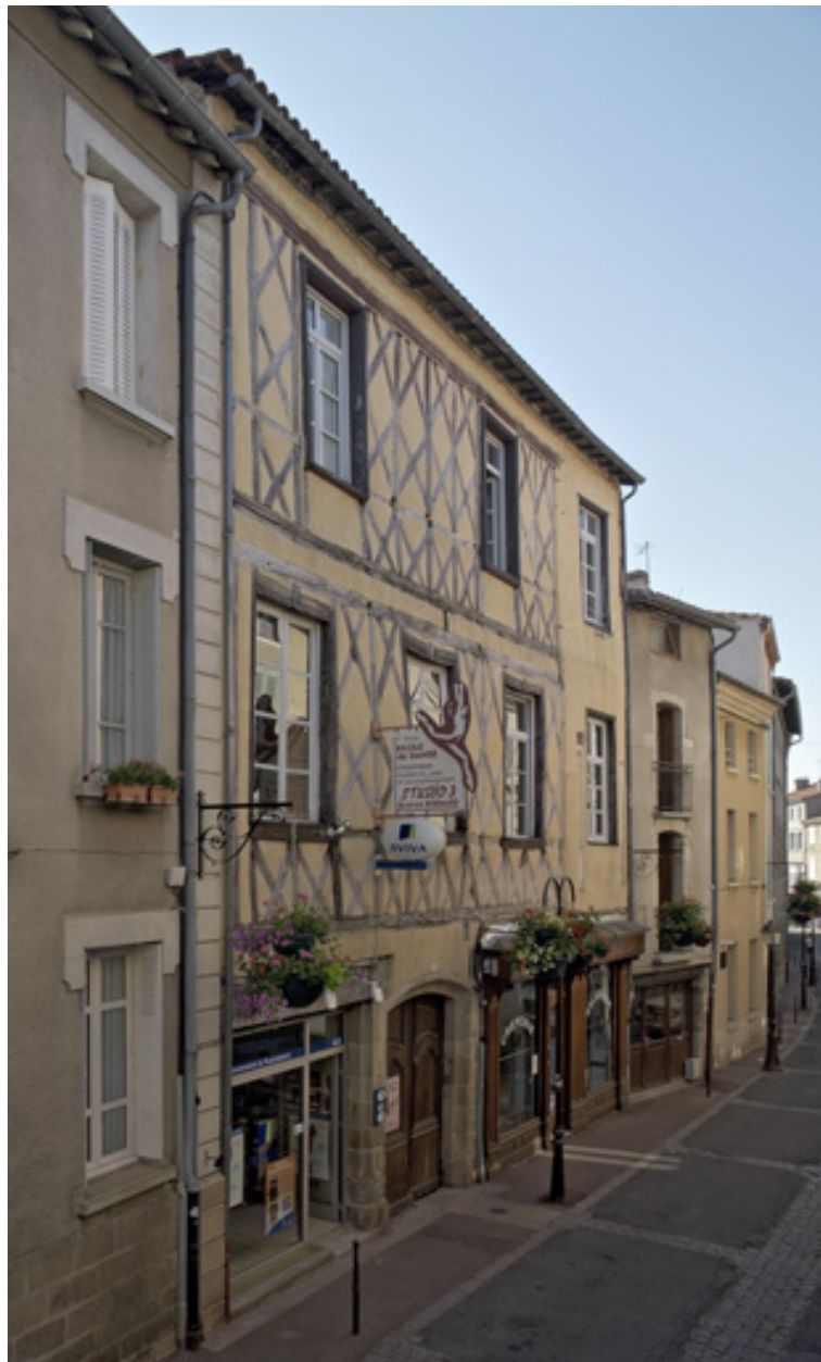
Vue de situation sur rue de trois-quarts gauche.
