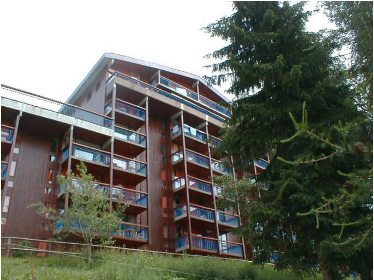
Façade ouest (aval)
