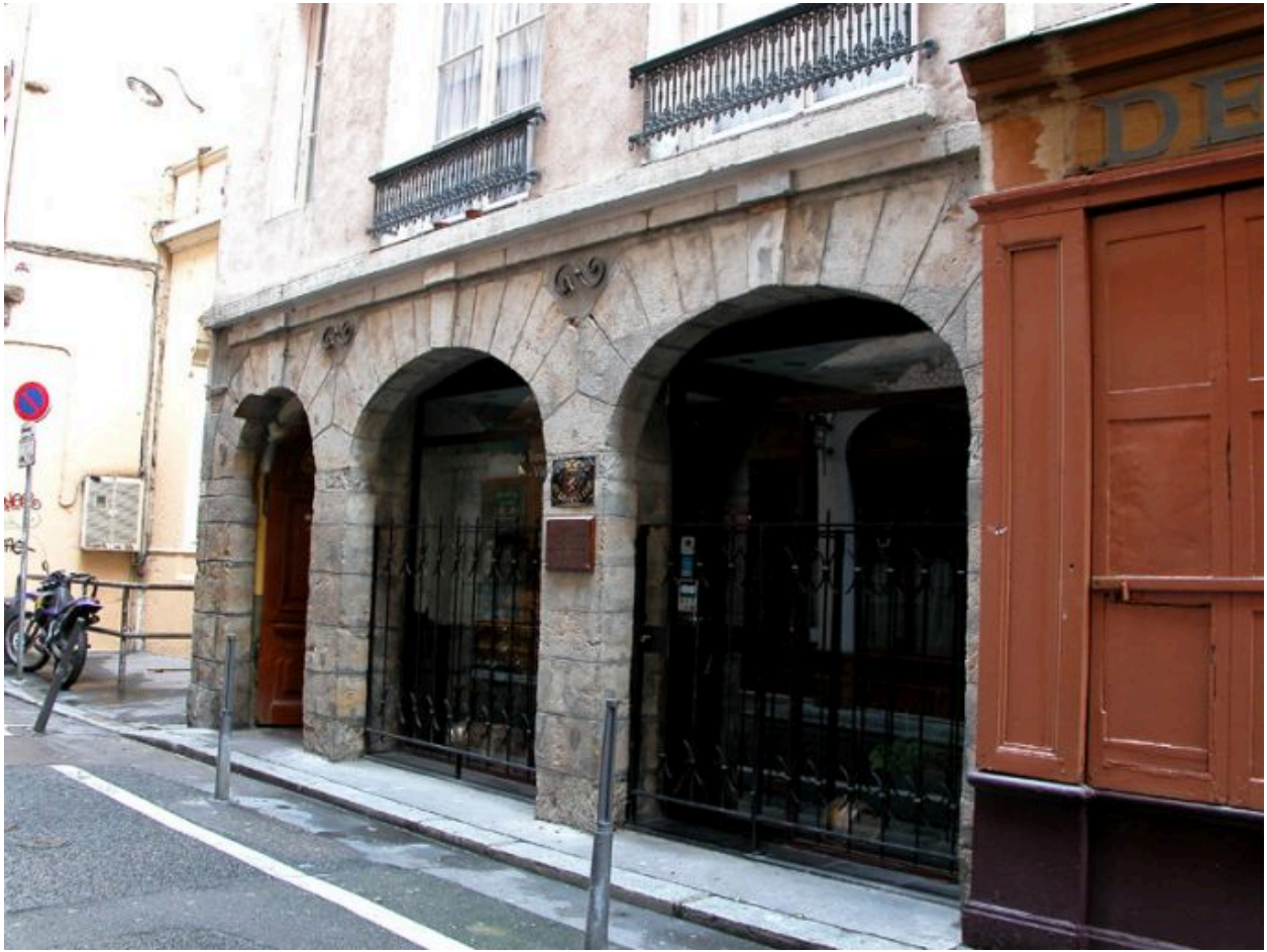
Façade sur rue, rez-de-chaussée
